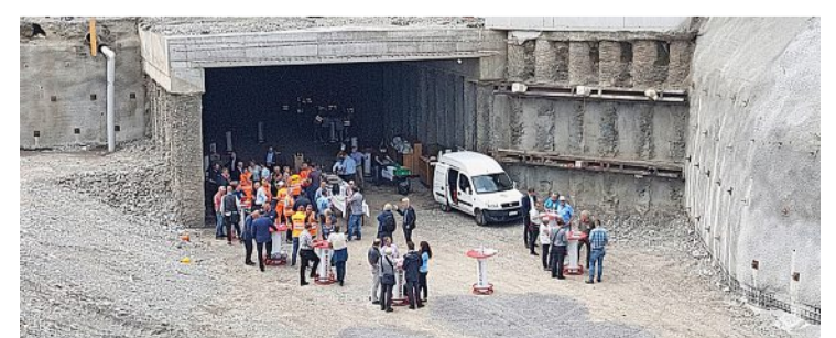
Der gestrige Spatenstich zur Umfahrung von Wilderswil stiess auf reges Interesse.
