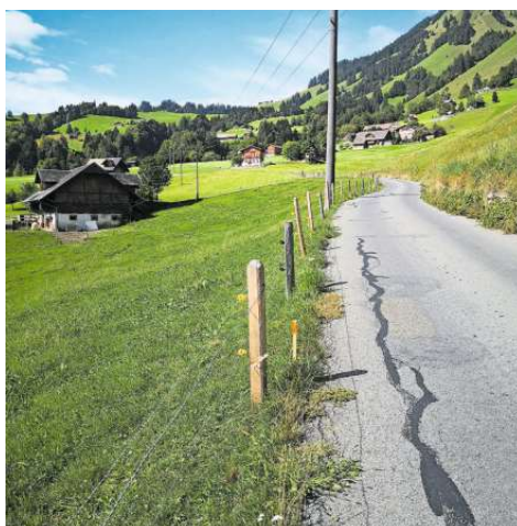
Bald starten auf der Wiesenbergstrasse wieder Bauarbeiten. Bild: PD
