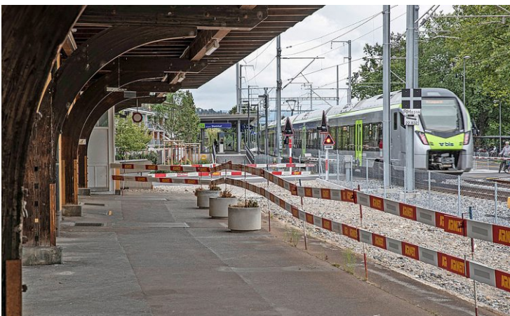
Das alte Stationsgebäude Steinhof (links) wird im kommenden Winter abgebrochen.
