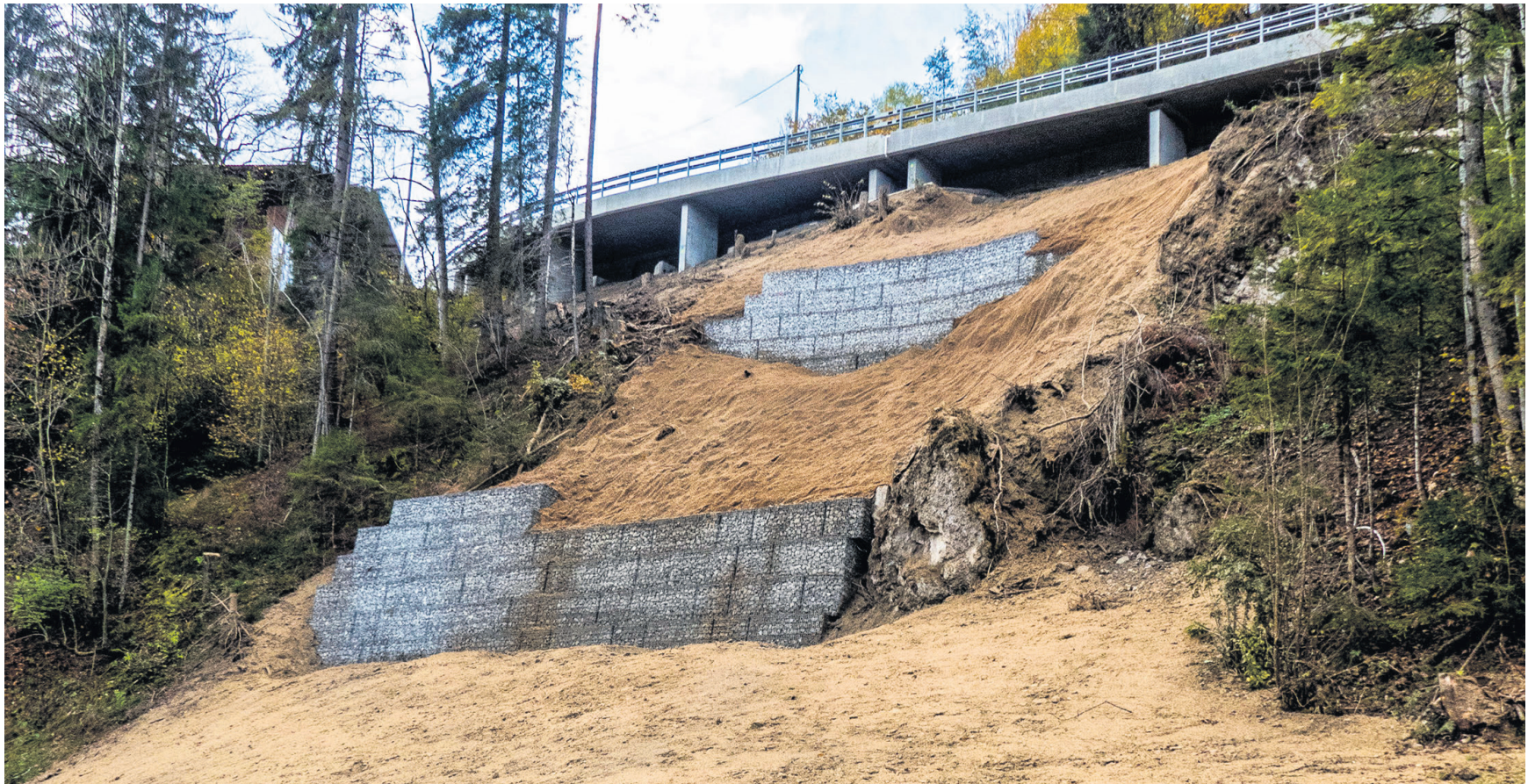
Die neu erstellte «schwimmende Brücke» an der Rutschstelle. Darunter ist die massive Hangsicherung zu sehen.
