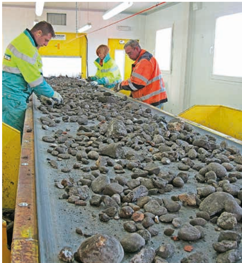
Wie beim Aushub der Deponie Geisschachen, im Rahmen des Hochwasserschutzprojekts Biberist / Gerlafingen, soll auch hier das belastete Material möglichst vor Ort aufbereitet werden (Triage).
