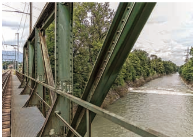
Im Projektperimeter überqueren drei Kantonsstrassenbrücken, drei Eisenbahnbrücken und eine Autobahnbrücke die Emme. (Bild: BLS-Brücke Biberist)
