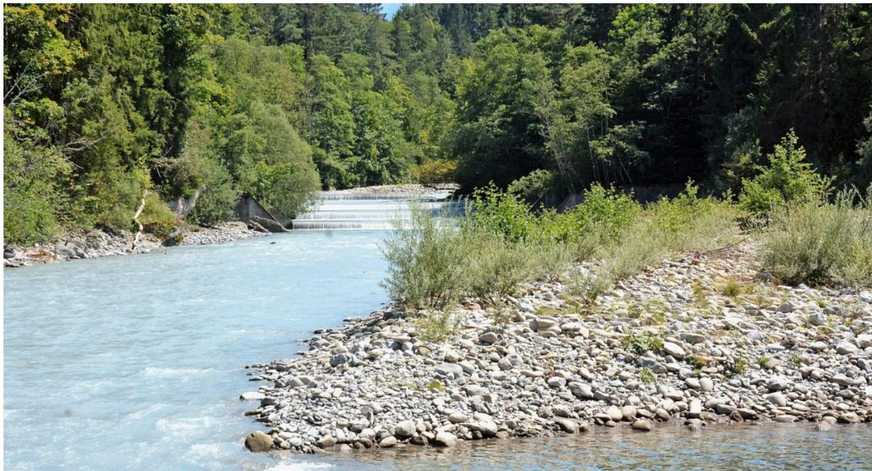
Oberhalb der Mündung der Simme (links) werden in der Kander sechs Betonschwellen durch aufgelöste Blocksätze ersetzt, die den Fischeaufstieg ermöglichen und den Hochwasserschutz verbessern. Foto: Guido Lauper
