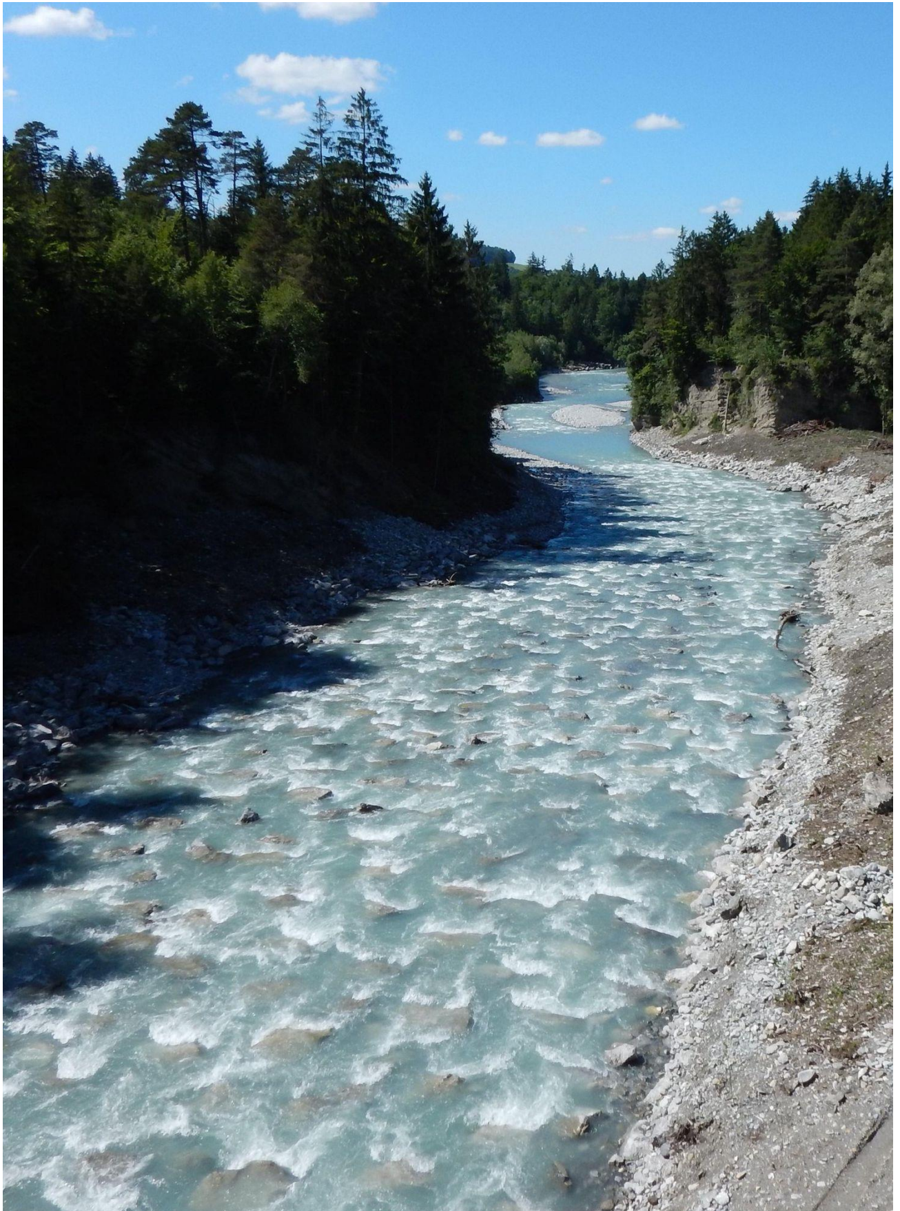
Mit einer 300 Meter langen Blockrampe präsentiert sich die Kander oberhalb der Simmemündung heute. Foto: Guido Lauper
