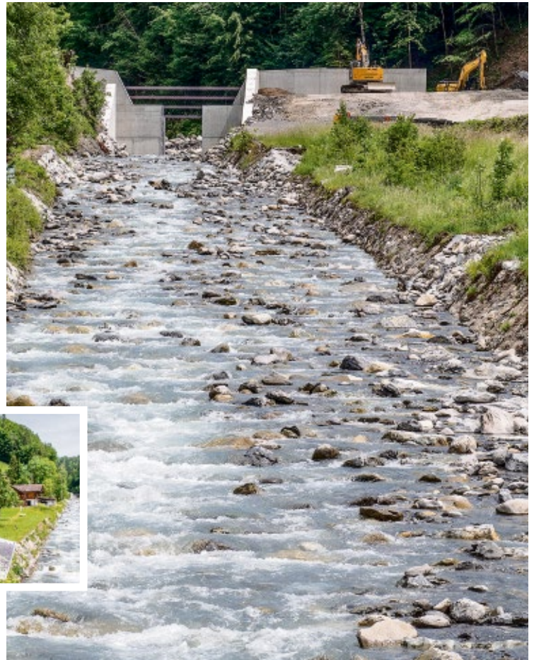
Planer Marcel Dähler (l.) und Bauleiter Christian Wüthrich erklären die baulichen Schutzmassnahmen vor Ort. Auf dem grossen Bild ist der riesige neue Geschiebesammler von unten gesehen, im Vordergrund das wieder fischgängig gemachte Bachbett. BILDER HSF
