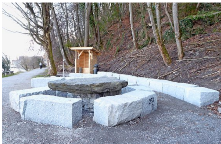
Die Arbeiten für die erste Feuerstelle am Strandweg, nahe der Fischzucht, sind beendet. Die Steine sind aus dem Tessin und St. Stephan.
