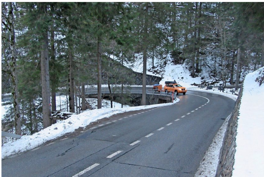
Im Bereich Marchgraben zwischen Achseten und Adelboden wird die Strasse um zwei Meter verbreitert, um ein besseres Kreuzen zu ermöglichen. Foto: PD
