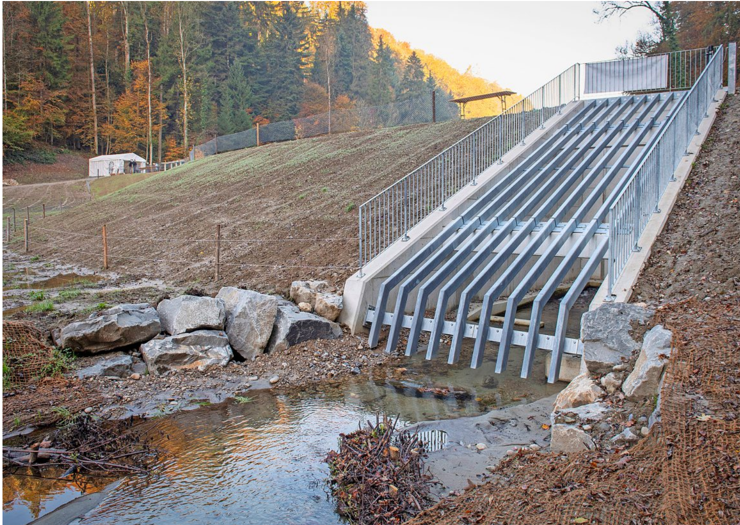
Der neue Rückhaltedamm beim Mutzbach hat seine erste grosse Bewährungsprobe bestanden. Fotos: Marcel Bieri
