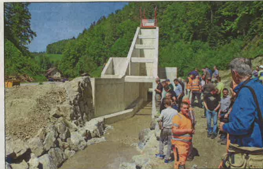
Zum ersten Mal floss das Wasser des Luterbachs durch das neu errichtete Durchlassbauwerk.
