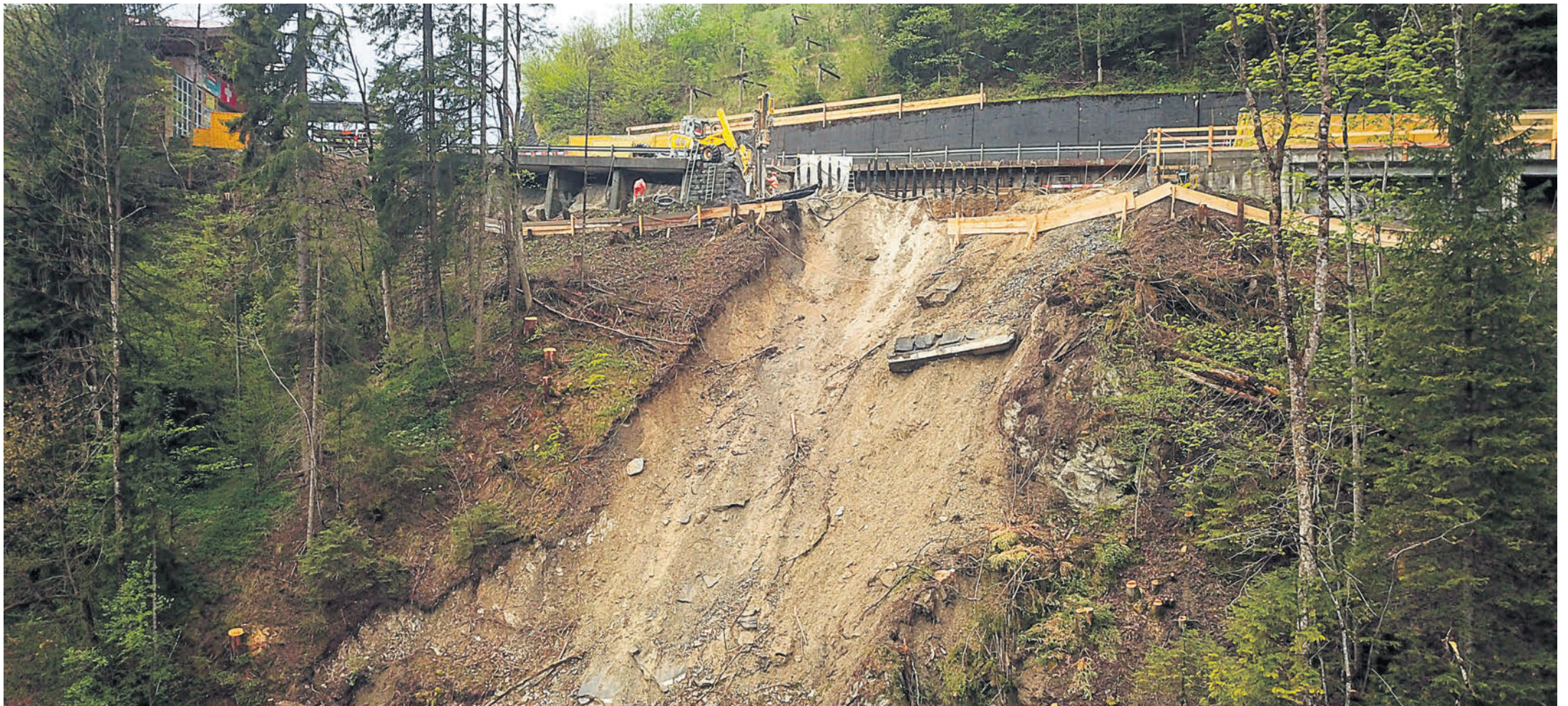
Der Erdbeben südlich des Linterflutunnels hat weithin sichtbare Spuren hinterlassen. Derzeit wird die Kantonsstrasse nach Adelboden wieder instand gesetzt.
