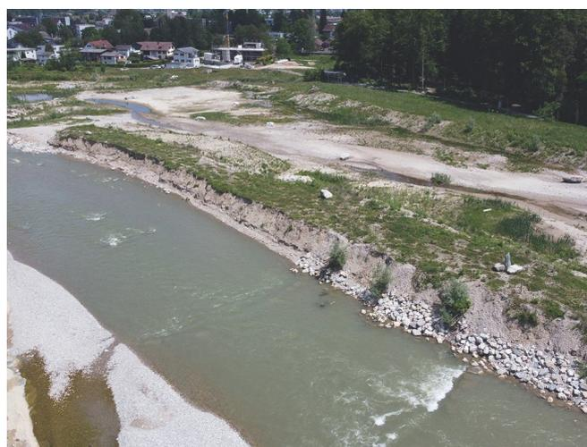
Abbildung 1: Kehrichtdeponie Schwarzweg während der Sanierung 2016/17 (Aushub 90'000 m<sup>3</sup>, links, Foto: AfU Kt. SO) und im Mai 2021 (rechts; Foto: IUB Engineering AG).
