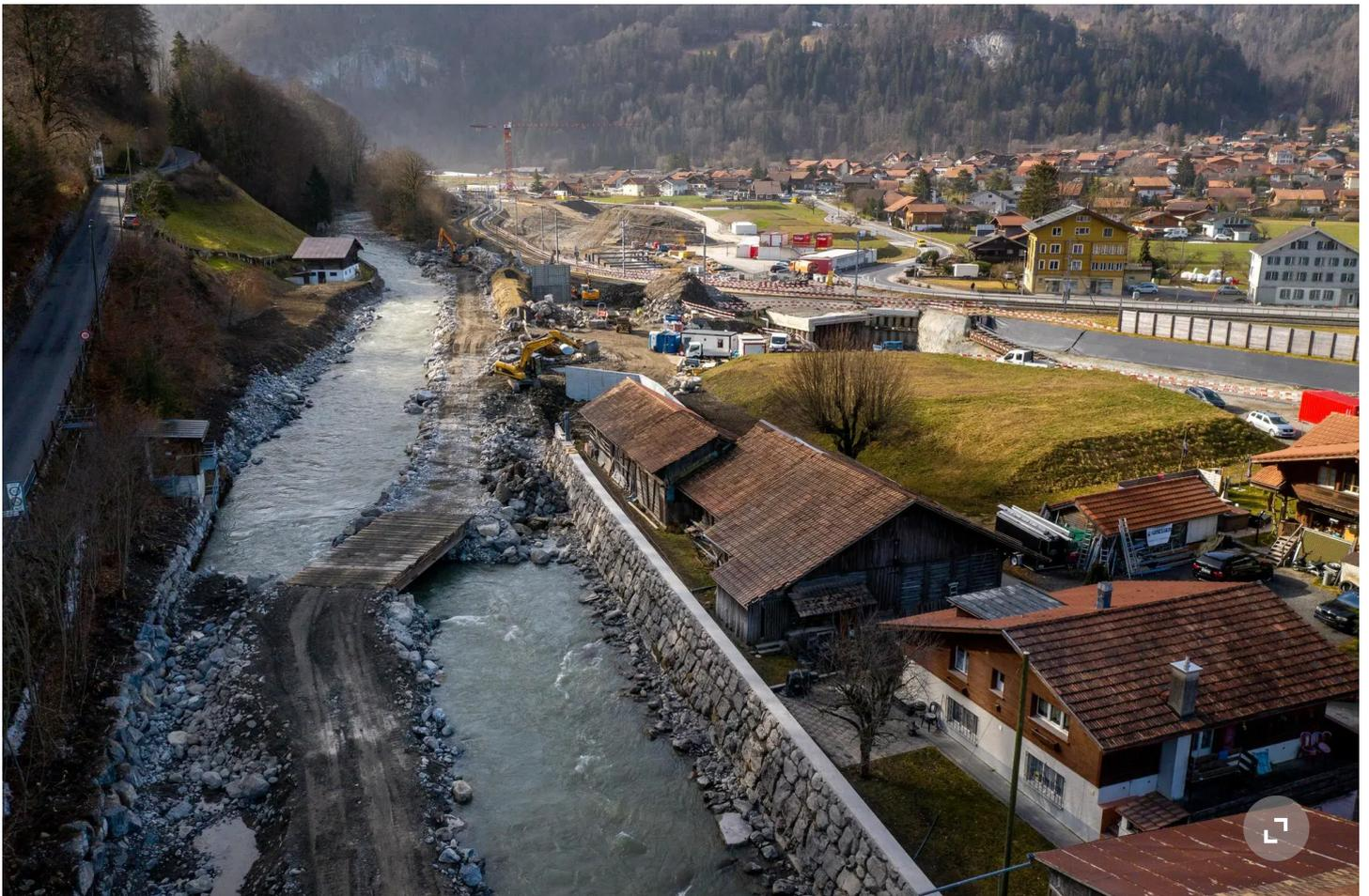
Im Vordergrund der mit Beton abgeschlossene Damm in Wilderswil, im Hintergrund die Baustelle für das Einlaufbauwerk beim Umfahrungstunnel.
