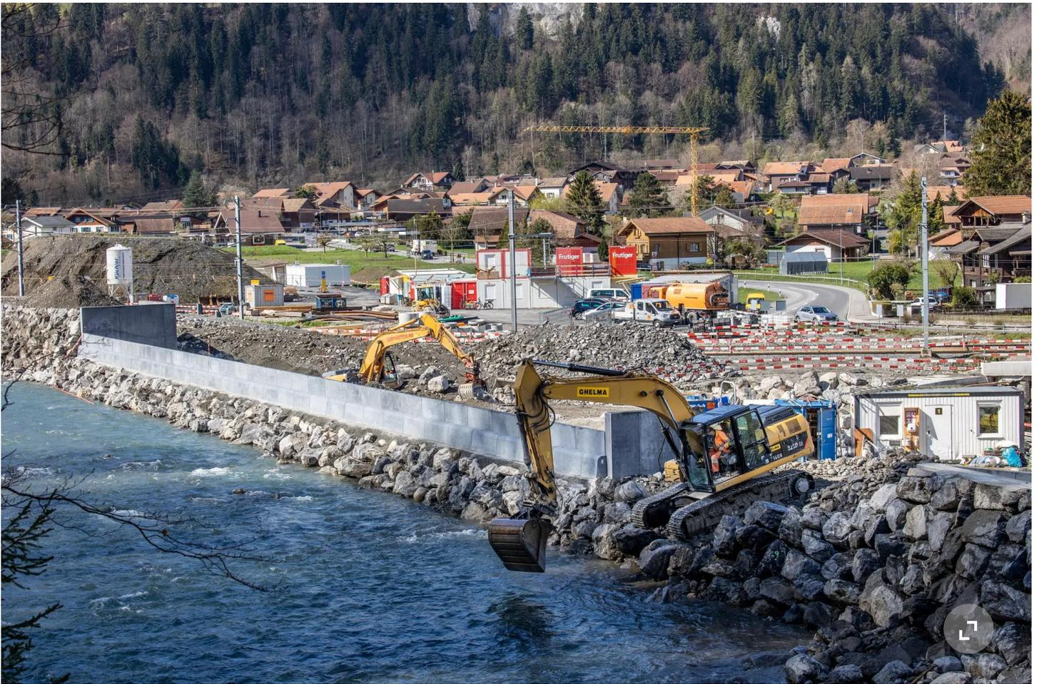
Das Einlaufbauwerk, das Hochwasser in den Tunnel leiten würde, im Bau.
