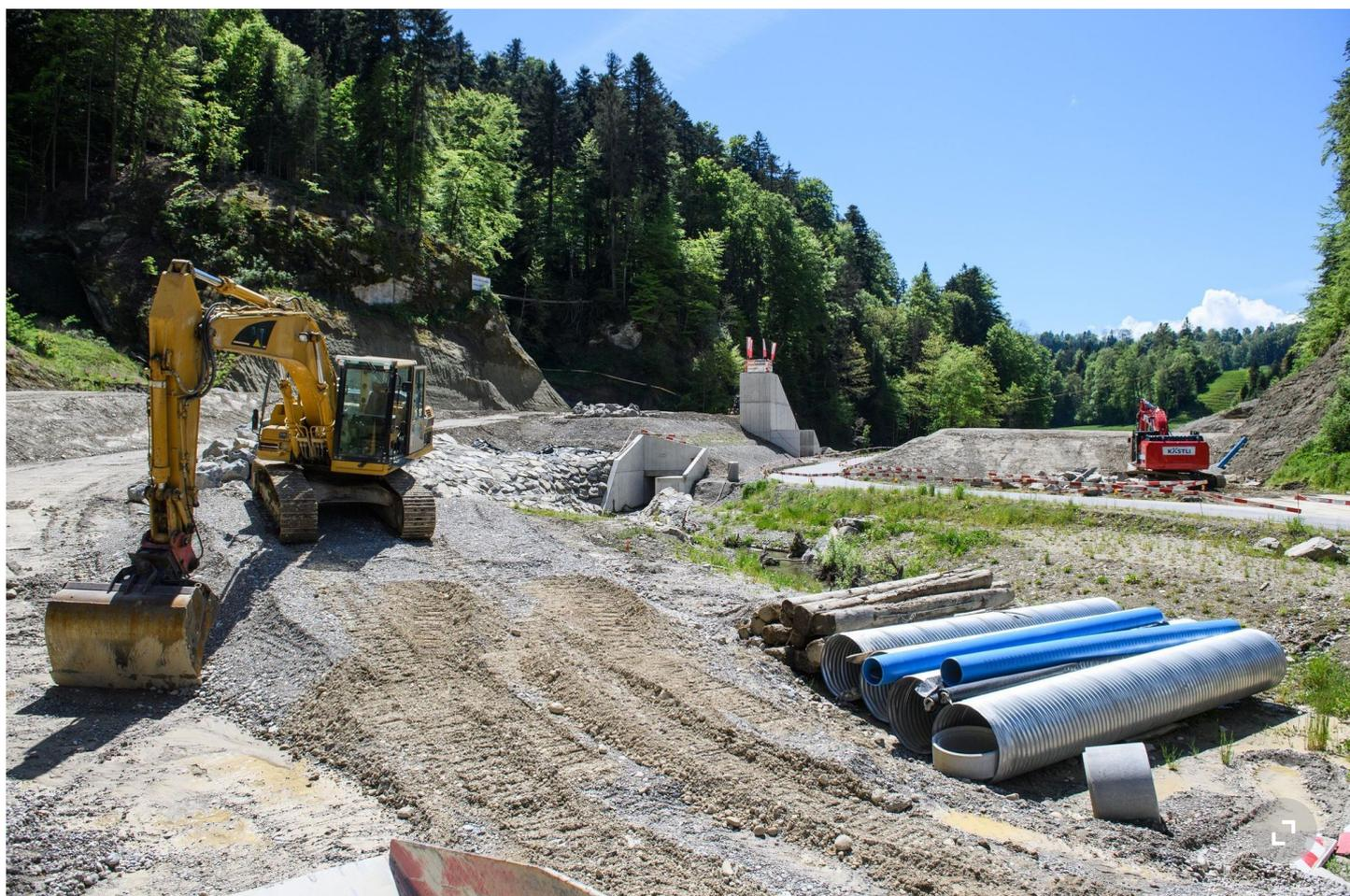
Der Bagger baut an der Rampe der Strasse, die dann auf der Höhe der Dammkrone quer über das Lauterbachtal führen wird.
