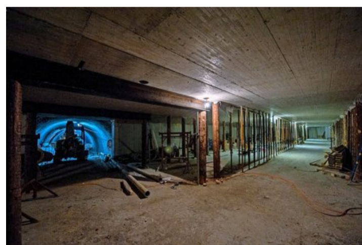
Das unterste Parkdeck wird noch mit Baumstämmen abgestützt.
