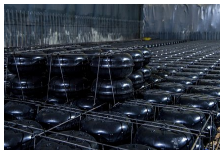
Diese Hohlkörper werden eingebaut, damit die Decke nicht zu schwer wird.
