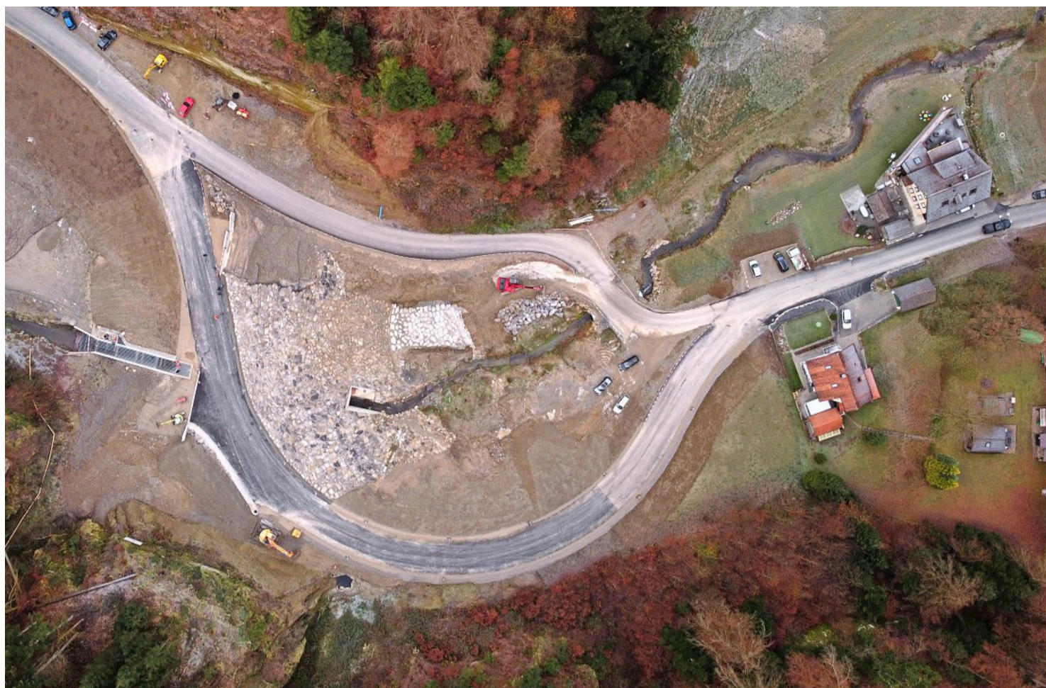
Die Strasse durchs Luterbachtal führt jetzt von der linken Talseite in einem weiten Bogen über die Krone des Hochwasserdamms. Foto: Beat Mathys
