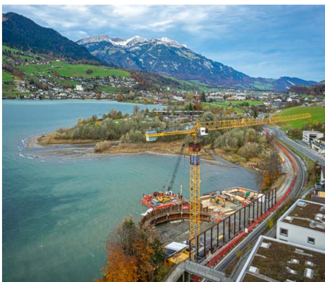
Baugrube des Einlaufbauwerks (vorne), darüber die Mündung der Grossen Melchaa in den Sarnersee, im Hintergrund Sarnen.
