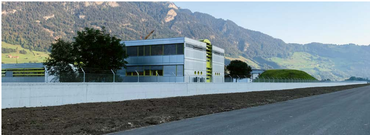
Die 800 m lange Betonmauer schützt als Objektschutzmassnahme das Flugplatzgebäude. Der Fotograf steht im Entlastungskorridor.
