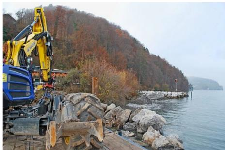
Wasserbauarbeiten werden per Bagger vom Ponton aus in Angriff genommen. Hier erste Teile der Bühne.
